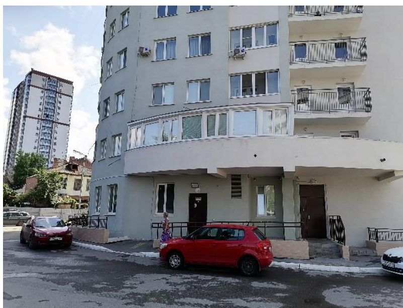
Рис. 4: Устройство дополнительного помещения на козырьке многоквартирного дома 3
